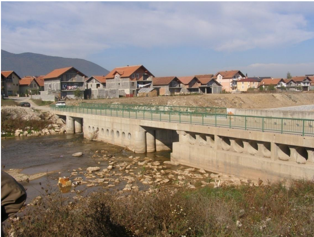
Slika 76. Pogled na ratni most sa uzvodne strane
